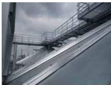
Металлические модульные структуры 700, 900 или 1100 мм шириной, адаптирующиеся к установке, чтобы облегчить обслуживание. Возможность стандартного пола или tramex.
