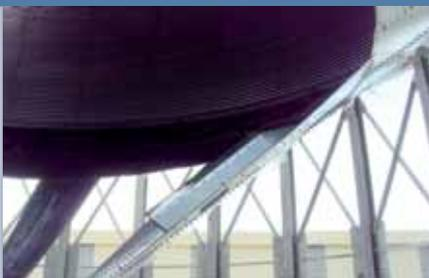
Система состоит из канала аэрации с отверстиями, прикреплённого к одному из секторов бункера, подготовленного для соединения с вентилятором.
