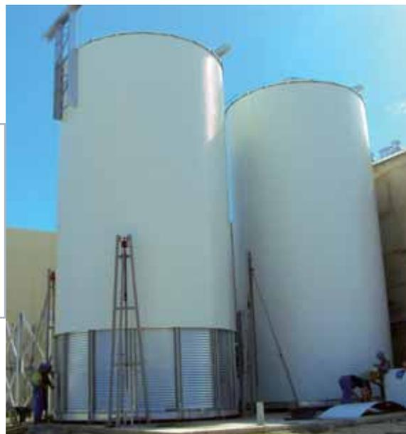
Внешняя обшивка обеспечивает дополнительную защиту от коррозии благодаря оцинкованным панелям с покрытием из полиэстера, в свою очередь, создавая дополнительную изоляцию. В наличии обшивка для крыши, цилиндра и воронки, белого, зелёного или синего цвета.
