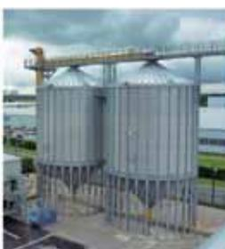
**СИЛОСЫ С НИЖНЕЙ МЕТАЛЛИЧЕСКОЙ ВОРОНКОЙ,** с углом наклона воронки 45° или 60°, в зависимости от текучести хранимого продукта, для разгрузки под силой тяжести
