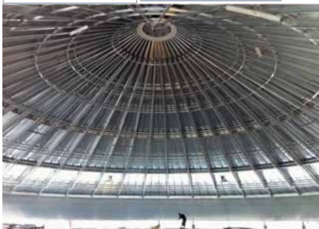
• Угол наклона в 30° позволяет оптимизировать объем хранения, адаптируясь под естественный наклон зерна.
