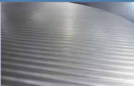
Представляет из себя полностью перфорированный пол из гальванизированной стали. Диаметр перфораций 1 или 1,5мм, в зависимости от вида хранимого продукта. Опоры выполнены из стали, оцинкованной горячим погружением.
